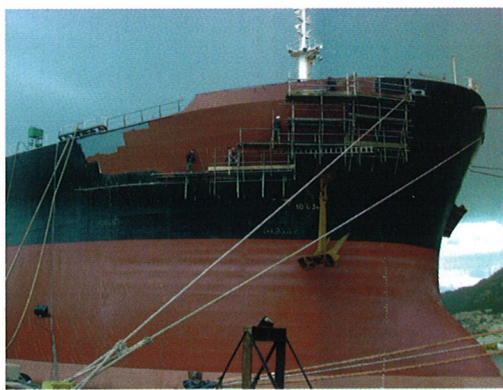
La bulkcarrier ALFA al termine della riparazione
